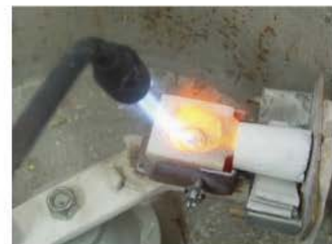
Figura 8.11 – Maçarico usado para fundir a liga metálica, que pode ser do tipo gás-ar ou gás-oxigênio.
